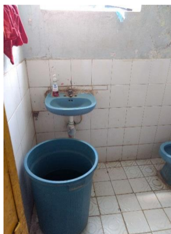
Sanitario (lavabo) – Biblioteca Pública
