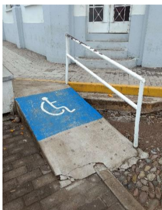
Rampa en guarnición – Presidencia Municipal
