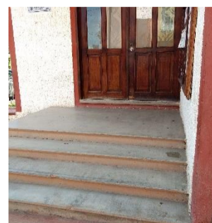
Escalera en acceso – Edificio Administrativo
