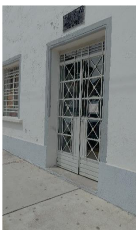
Puerta exterior – Biblioteca Pública
