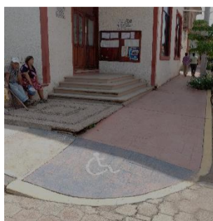
Rampa en banqueta – Edificio Administrativo
