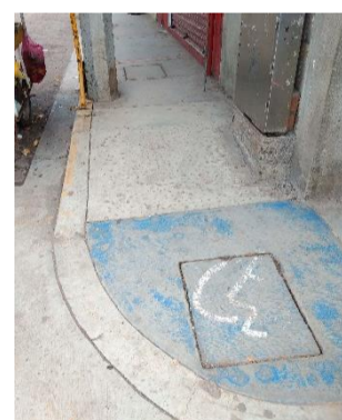
Rampa en banqueta – Mercado Municipal
