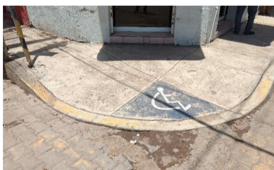
Rampa en banqueta – Mercado Municipal
