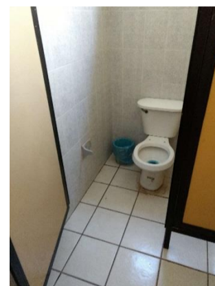
Sanitario (inodoro) – Edificio Administrativo
