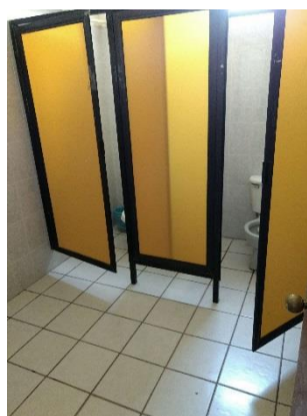
Sanitario (gabinetes) – Edificio Administrativo
