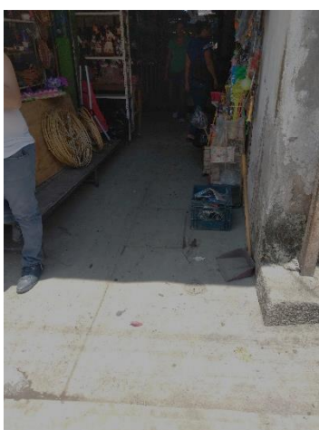
Rampa – Mercado Municipal
