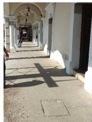
Pasillo exterior – Presidencia Municipal
