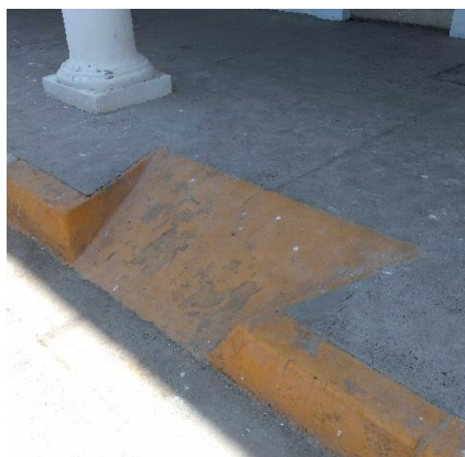
Rampa en guarnición de banquetta – Presidencia Municipal
