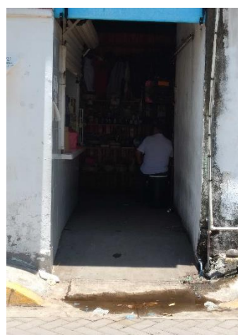
Rampa – Mercado Municipal
