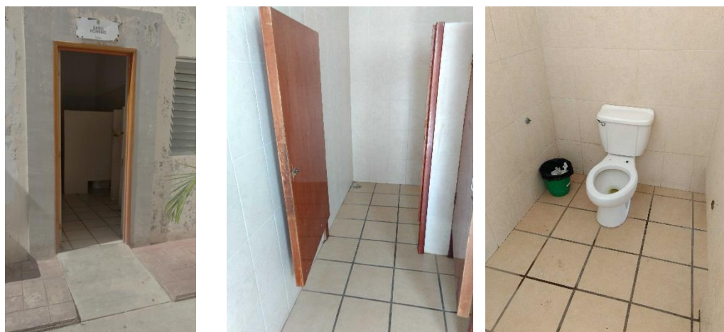
Sanitarios (acceso y gabinetes de inodoros) – Presidencia Municipal
