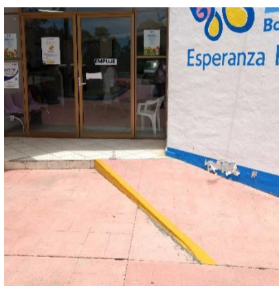
Rampa en entrada principal – D.I.F. Municipal
