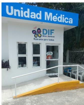
Rampa en acceso – Unidad Médica del D.I.F. Municipal
