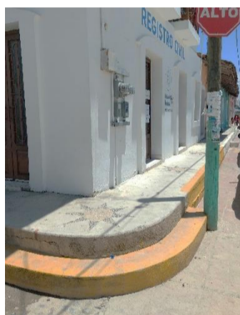
Banqueta en esquina – Dirección del Registro Civil
