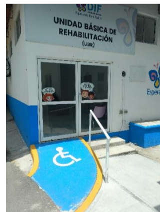
Rampa en acceso – Unidad Básica de Rehabilitación del D.I.F. Municipal
