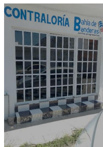
Escalones en puerta exterior – Contraloría Municipal
