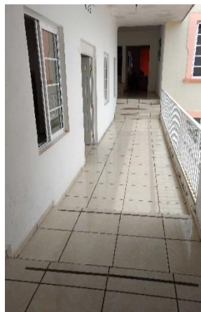
Escalones en pasillo de planta alta – Presidencia Municipal
