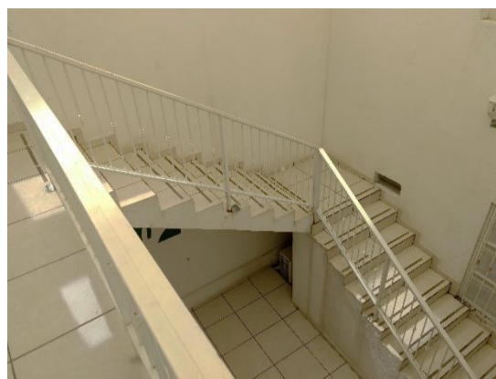
Escalera (acceso lateral) – Presidencia Municipal
