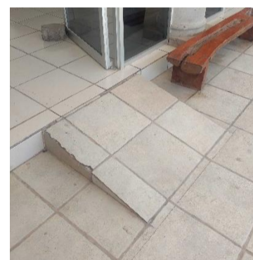
Rampa en entrada principal – D.I.F. Municipal
