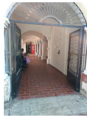
Puerta exterior lateral – Presidencia Municipal
