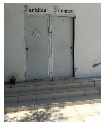
Escalones en acceso a oficinas – D.I.F. Municipal
