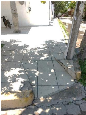
Rampa en esquina – U.B.R.
