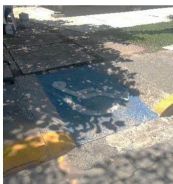
Rampa en banqueta – D.I.F. Municipal
